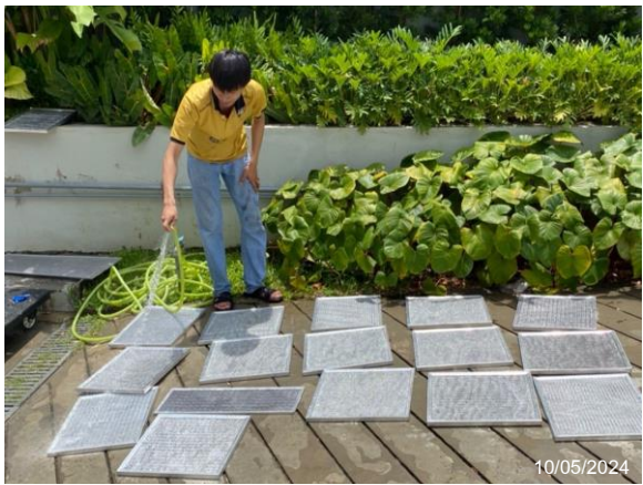
รูปที่ 3-6 การล้างทำความสะอาดเครื่องปรับอากาศ
