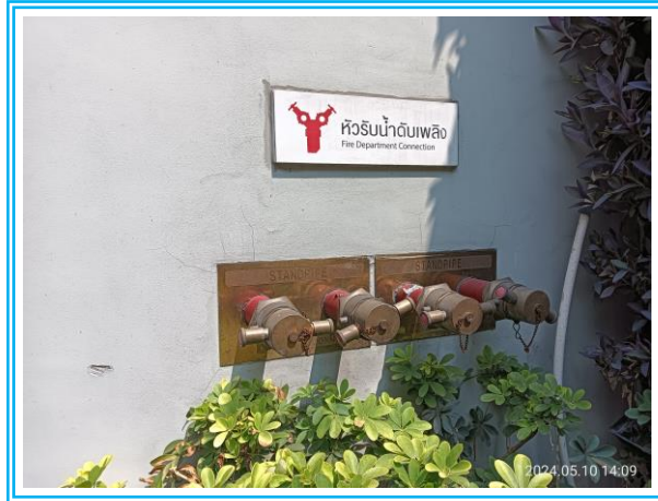
รูปที่ 3-56 หักรับน้ำดับเพลิงภายในโครงการ
