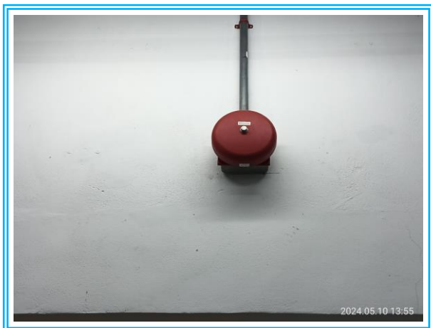
รูปที่ 3-53 อุปกรณ์ส่งสัญญาณ และแจ้งเหตุเพลิงไหม้
