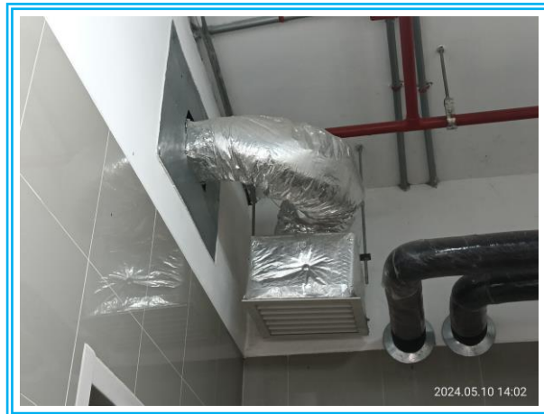
รูปที่ 3-31 ท่อพัดลมดูดอากาศภายในห้องพัสดุ
