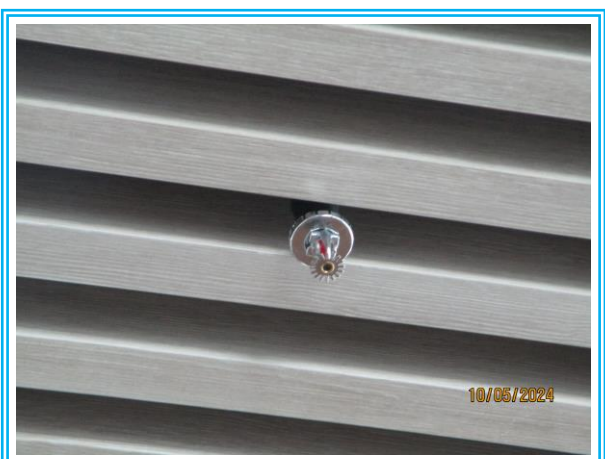
รูปที่ 3-55 หัวกระจายน้ำดับเพลิงอัตโนมัติ
